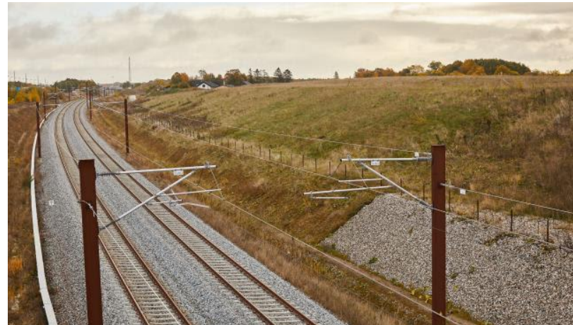
Abb. 5: Beispiel für Corten-Stahlprofilmaste, nach [1]
