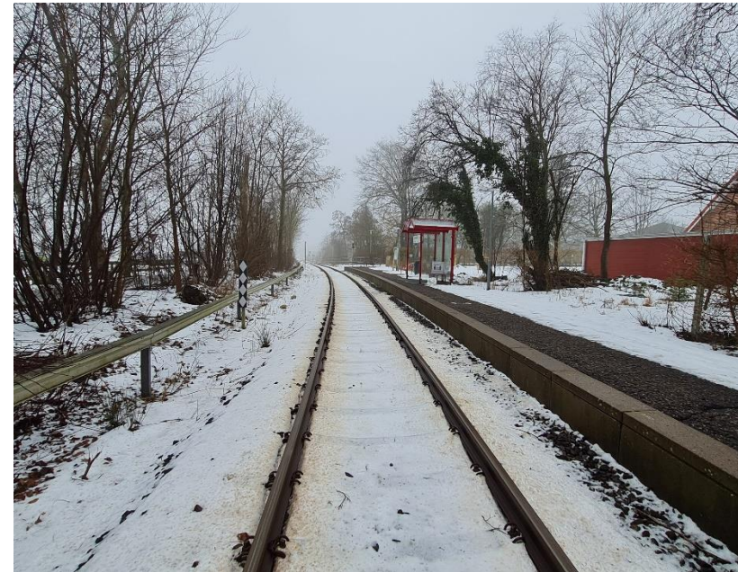
Abb. 14: Beispiel Kabeltrog (links)
