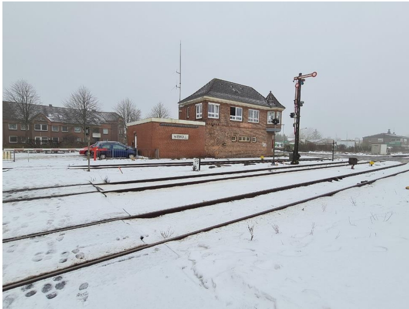
Abb. 13: Stellwerk N1 Bf Niebüll
