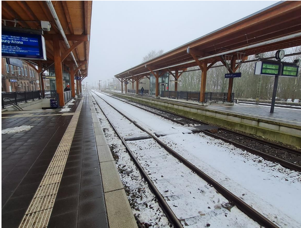
Abb. 3: Bahnsteigüberdachung Bf Niebüll DB
