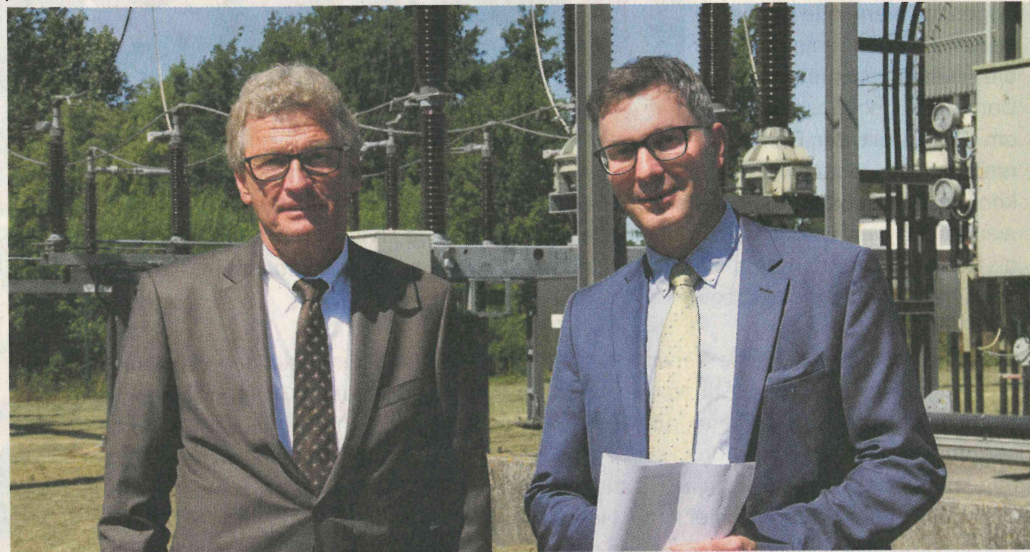
Ingo Dewald (re.) hat in Minister Dr. Bernd Buchholz einen Unterstützer bei den Plänen zur Elektrifizierung der Strecke Niebüll/Dagebüll. Im Umspannwerk Gasthafen (Klockries) soll die Windenergie auf die nötige Spannung gebracht werden, die für den elektrischen Antrieb von Zügen notwendig ist.
